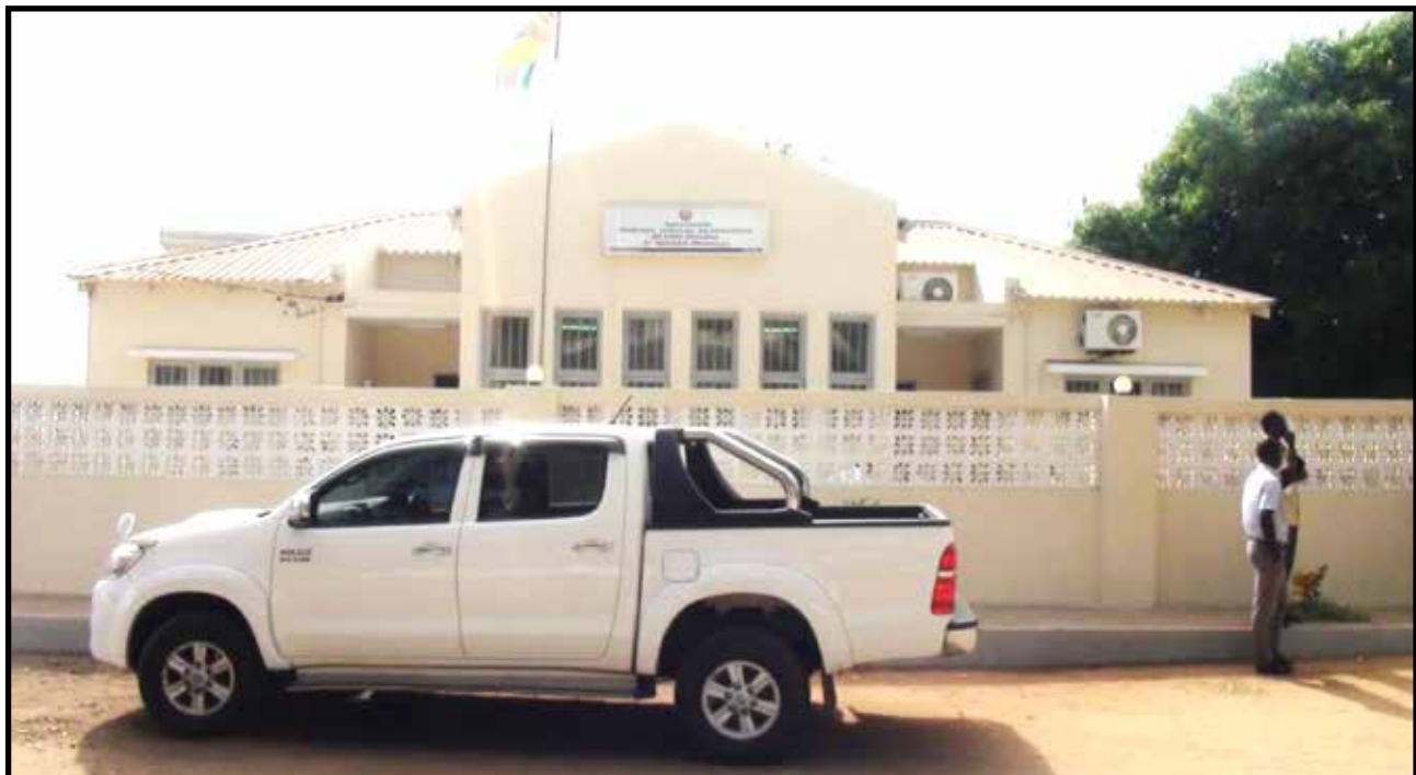
Edifício da 5ª. Secção de Menores do Tribunal Judicial da Província de Cabo Delgado, inaugurado.
